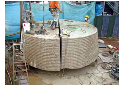
▲杭体切断状況
