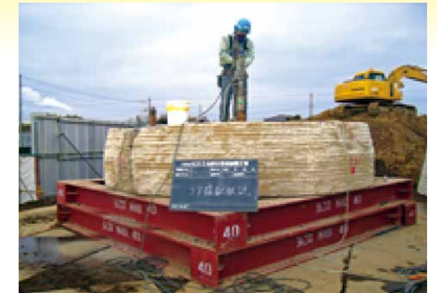
▲コアボーリング状況
