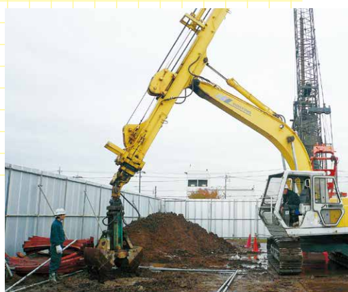
▲機械併用による掘削
